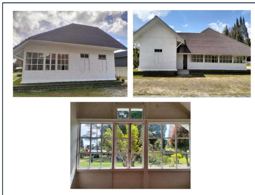
Gambar 1 Gambar Bangunan Pengasingan Sukarno di Brastagi
